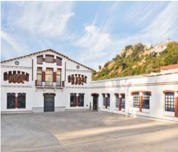
Weaving plant. Santa Maria d'Oló, Barcelona.
