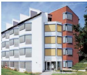
**La persiana exterior con láminas de 50 mm de ancho** y guía de cable tensor se recomienda especialmente para los edificios con ventanas de menores dimensiones. Entre sus ventajas cabe destacar su caja de altura reducida, así como las diversas variantes del sistema de accionamiento.
