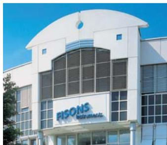
**Las persianas venecianas exteriores con láminas planas** se distinguen por su fino diseño de filigrana y por su caja de altura reducida. Estas persianas se fabrican con láminas de 60 mm, 80 mm y 100 mm de ancho.
