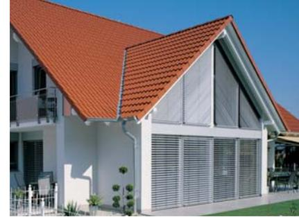
El factor de reducción FC puede variar entre 0 (en teoría, con una protección solar óptima) y 1 (sin ninguna protección solar).
